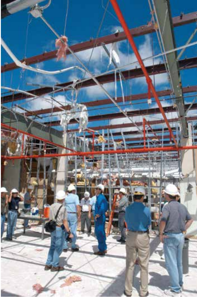
Los miembros de un equipo de evaluación de huracanes observan los daños en el techo de la Instalación de Sistema de Protección Térmica (TPS por sus siglas en inglés) en el Centro Espacial Kennedy después del huracán Frances (2004). La instalación, que creó los azulejos del TPS, las capas y todos los sistemas de control térmico interno para los transbordadores espaciales, era casi totalmente inservible tras perder aproximadamente el 35 por ciento de su techo.
